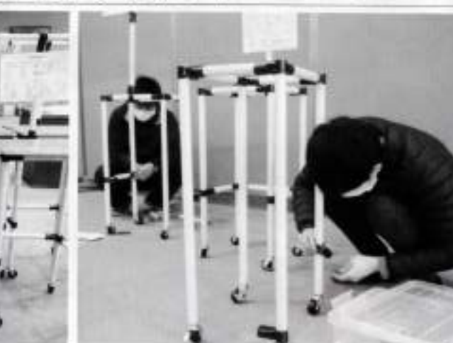
パイプツールを活用しての作業
